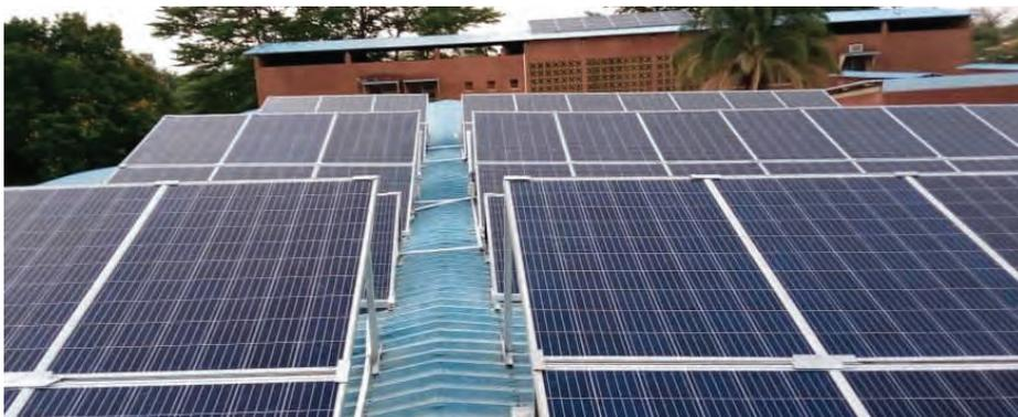
Pour ce projet, 400 panneaux solaires sont installés, permettant de fournir une puissance solaire totale de 45 Kilowatts
