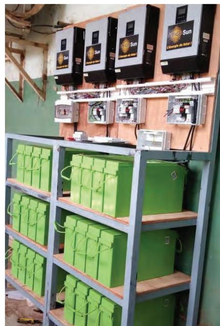
Le système est doté de batteries et d'onduleurs hybrides
